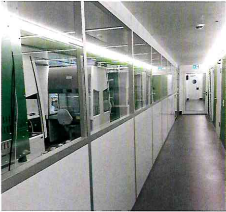
Das 100 qm grosse Reinraumlabor wurde speziell für die beengten Räumlichkeiten geplant und erreicht die Reinraumklasse GMP B.
