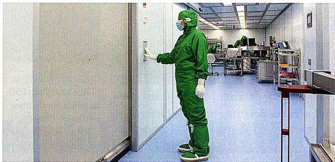
Die 12 m<sup>2</sup> große Materialschleuse erreicht die ISO-Klasse 7 und wird durch Schnelllauf-Rolltore vom Reinraum getrennt.
